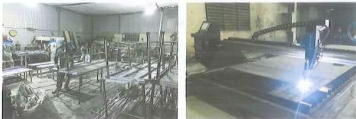
Hình 1.6. Một số hình ảnh công đoạn cắt
